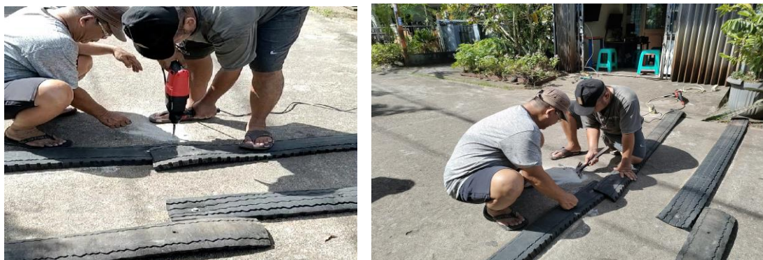
Gambar 4. Pemasangan Ban ke Badan Jalan.
